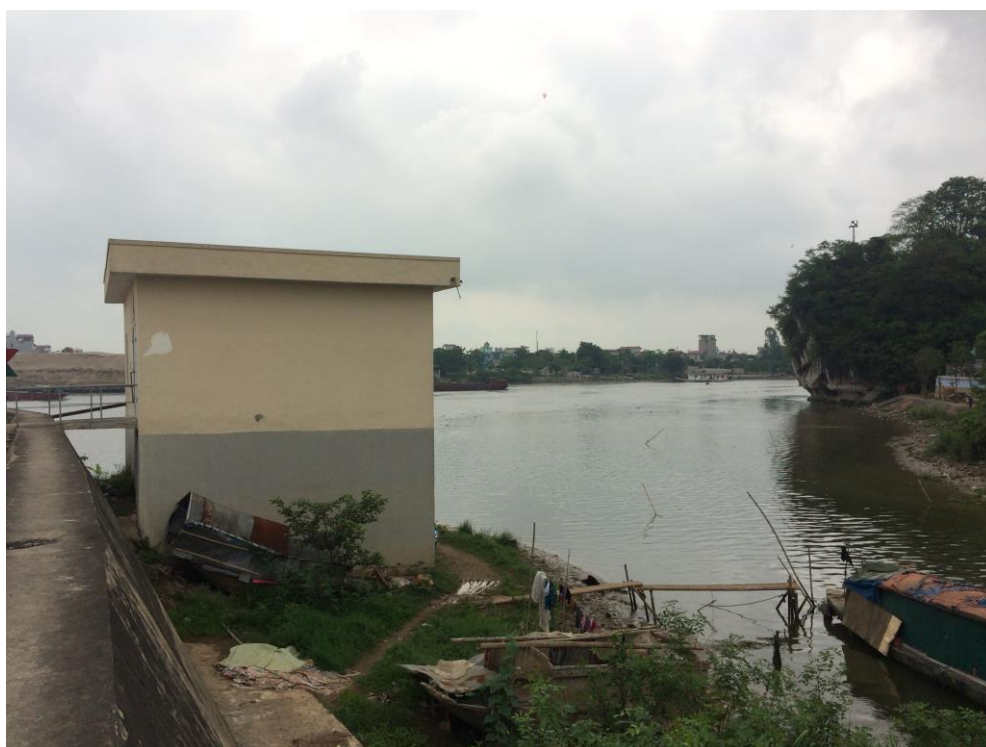
Hình 02. Trạm thu nước đầu vào của Nhà máy nước Ninh Bình
