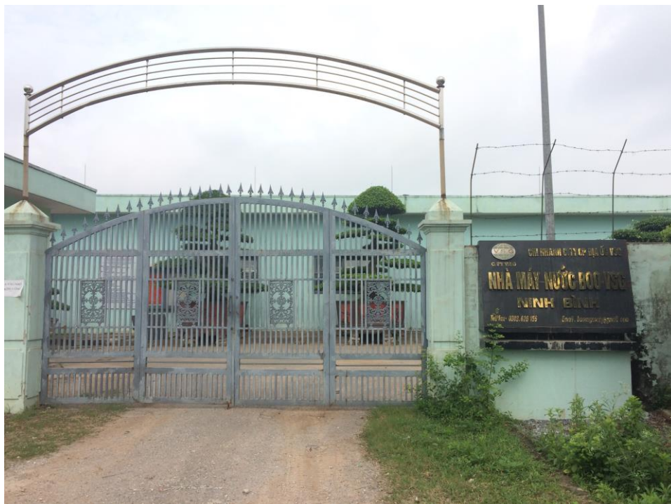
Hình 01. Nhà máy nước BƠ VSG
