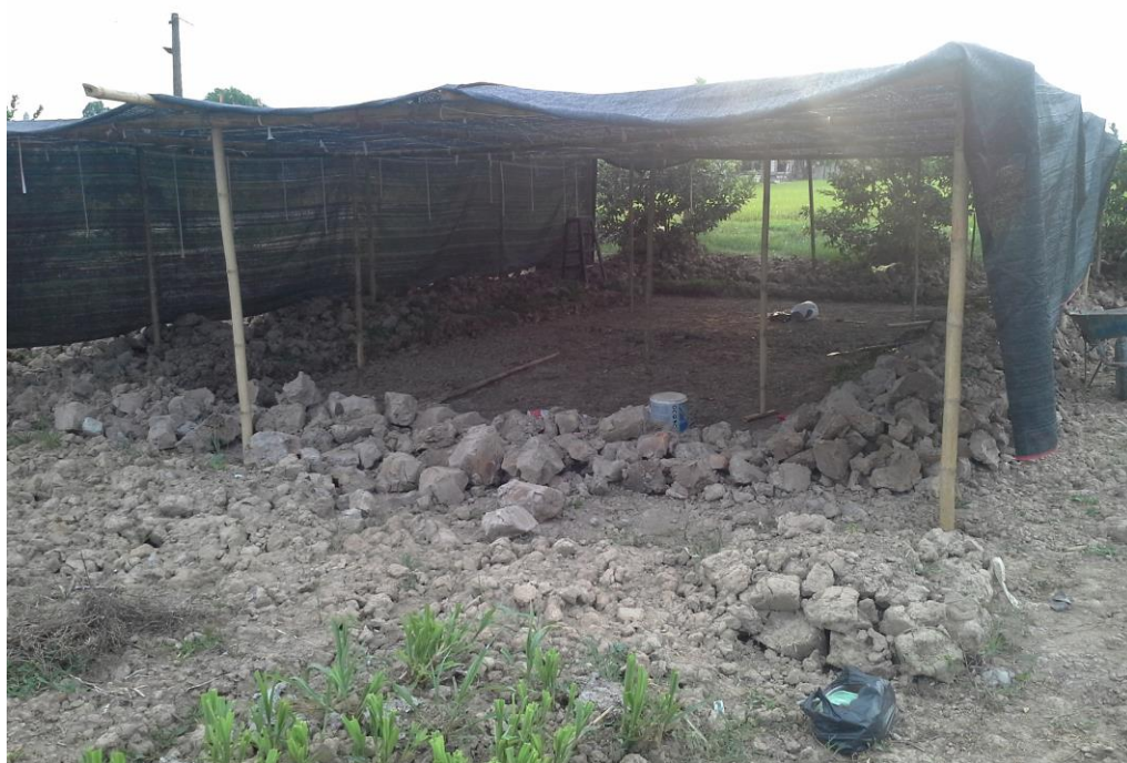
Hình 2.3.2. Chuẩn bị dựng khu bể bạt
