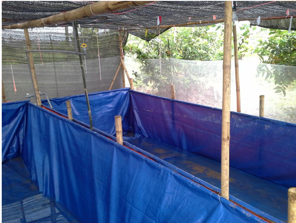
Hình 2.3.3. Dựng xong khu bể bạt
