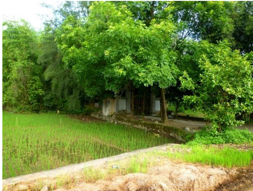
Hình 1.2. Cống đê Kê Hạ (Ảnh sưu tầm)
