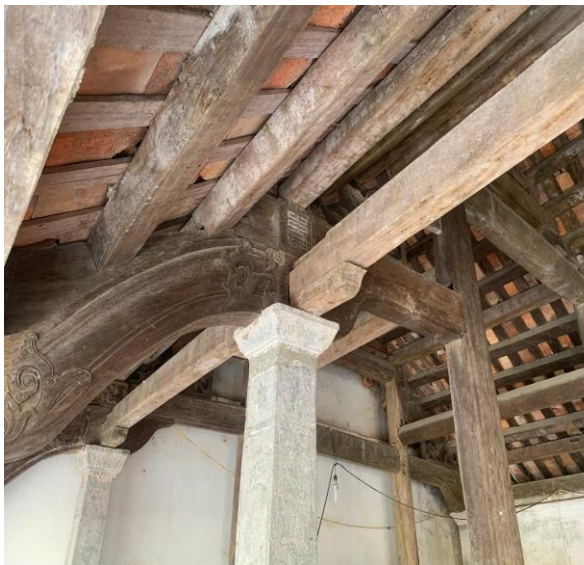
Hình3: Kết cấu mái xà tại đình Vân Trình(Mai Trung Hiếu, 10/3/2026)
