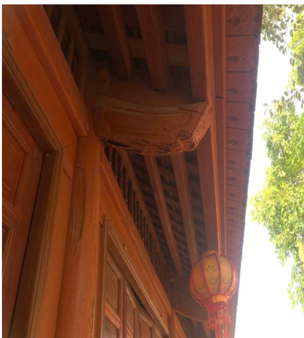
Hình ảnh 15: Kết cấu mái xà khu vực bài đường tại đình Vân Trung (Mai Trung Hiếu, 30/3/2026)
